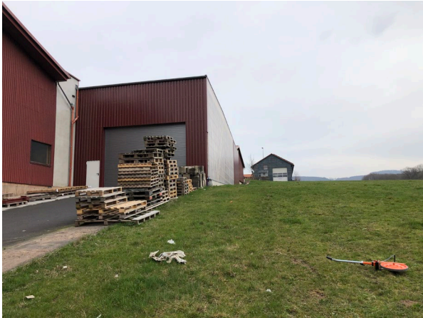
Blick von Nordwesten auf die bestehende Halle und Erweiterungsfläche“
