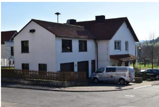
Abb. 55: DGH Batten mit Anbau (links) und Haupteingang mit Feuerwehrrhalle (rechts)
